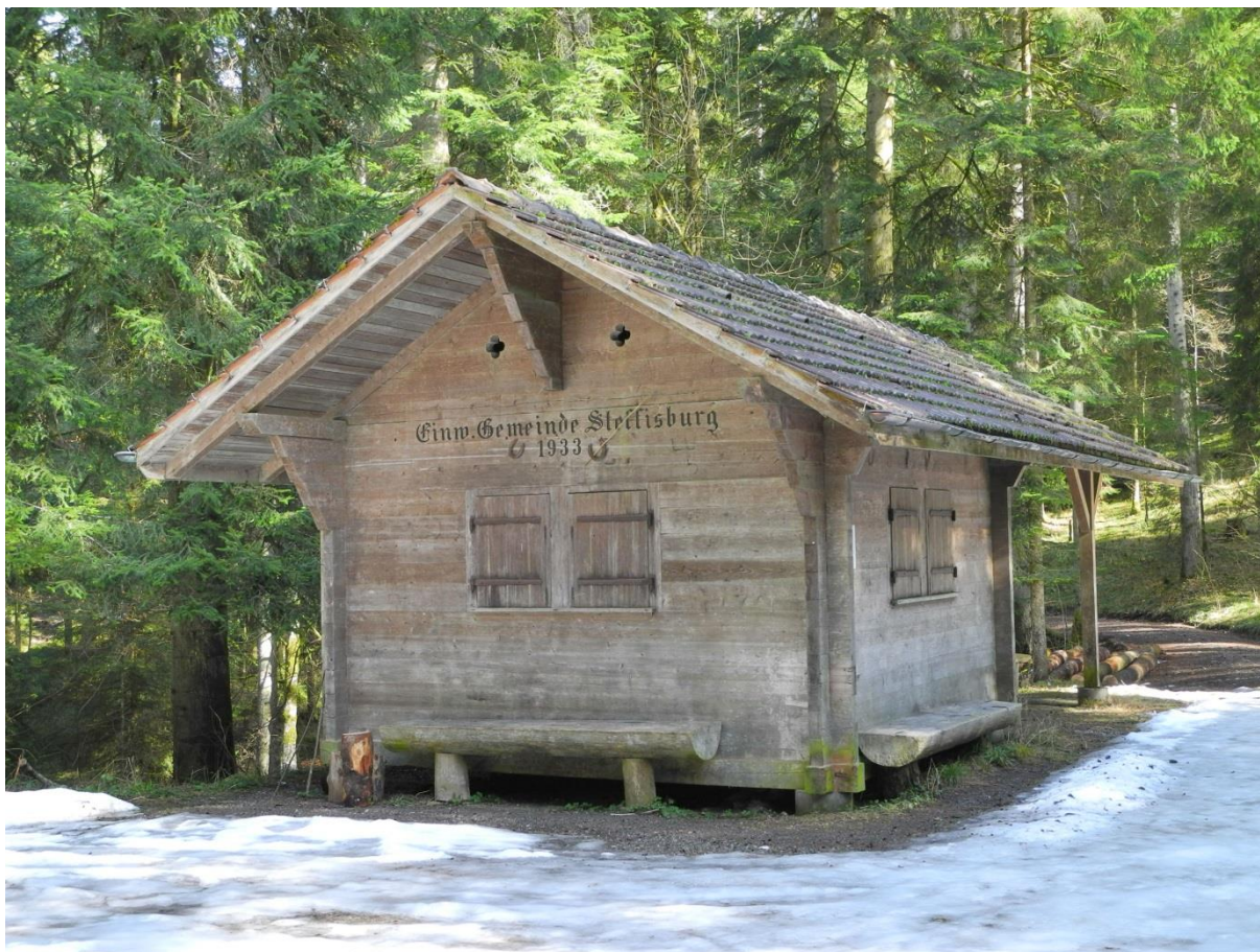
Figure 5 : Cabane forestière du Neuenbann érigée en 1933, propriété de la commune de Steffisburg.
